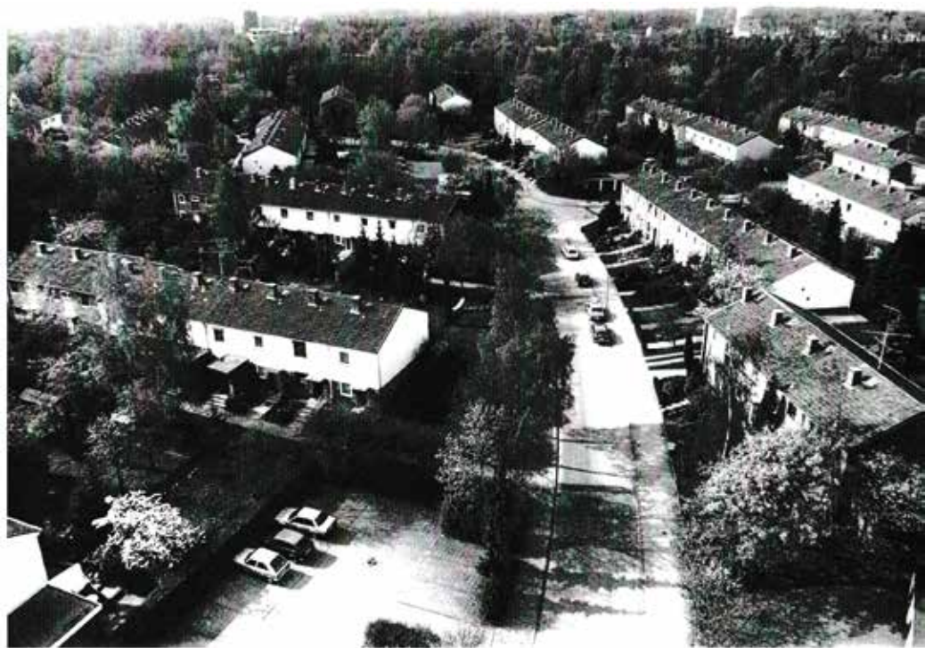
gerade fertiggestellt und bezogen. Blick von einem Baukran
