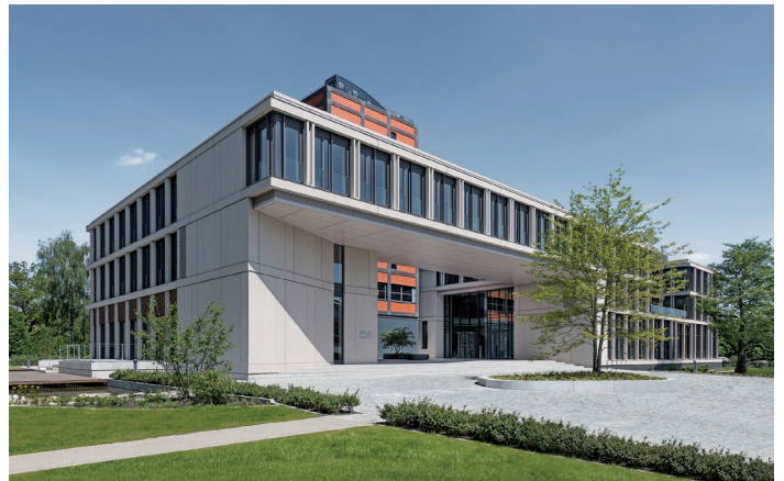
Das „Achim und Petra Herz Haus“ Gebäude, Sitz der Joachim Herz Stiftung an der Langenhorner Chaussee. Im Hintergrund ist der Röstturm zu erkennen. © Kitzmann Architekten mit Heiner Laska
